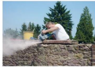
Restaurierung der Friedhofsmauer
