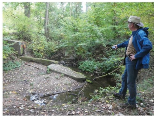
Abb. 1. Vom westlichen Stauwehr im Heegbach sind nur noch Mauerreste erhalten. Auch dieses erlaubte eine Aufstauung von etwa 2 Metern.
